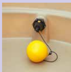
Installation et réglage de la hauteur grâce au fil
