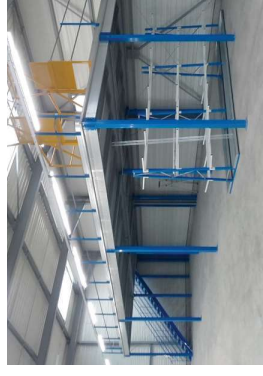
Exploitation du volume d'un entrepôt, en augmentant la surface de stockage au sol grâce à une plate-forme ACTIFLOOR
