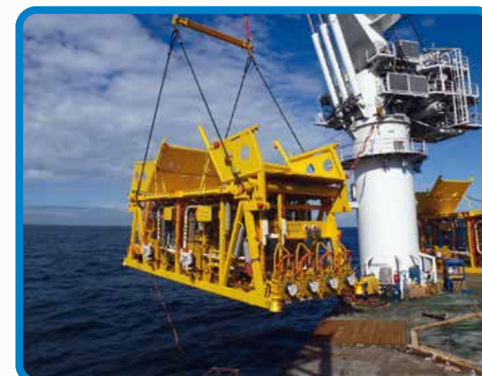
Poutre d'écartement sous-marine
