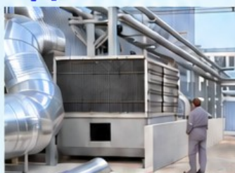
Récupération sur fumées et effluents gazeux
