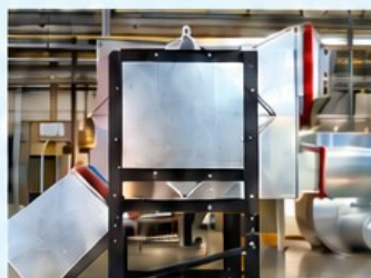
Préchauffage d'air neuf par l'air extrait du process
