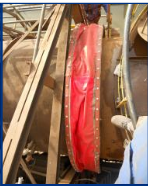
recouvrement d'un compensateur métallique avec un compensateur en textile
