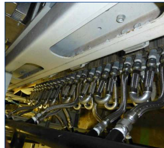
Flexibles coudés à 180° Application batterie de refroidissement.
