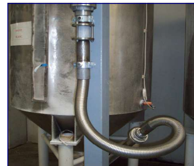
Flexible avec regard de contrôle en verre
