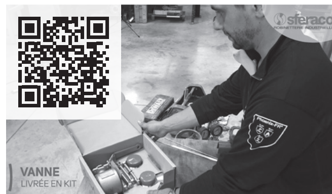
Montage de la vanne Elsa® en préfabrication.
