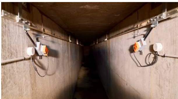
Moteur individuel par tringlerie guidée indépendamment
