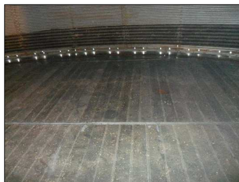
Ventilation par plancher perforé
