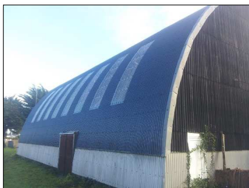
Couverture et bardage
