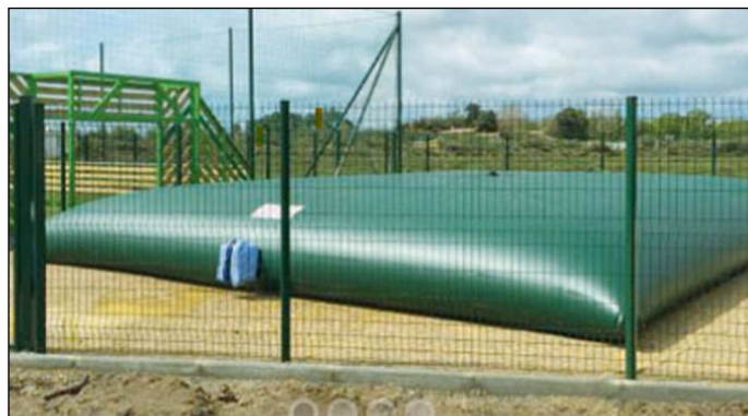
Réserves souples incendie
