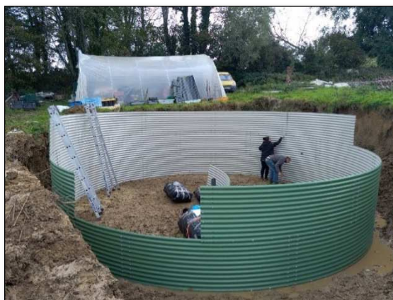
Montage réserve d'eau
