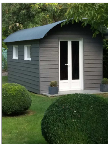
Toitures roulote, abris de jardin, etc.
