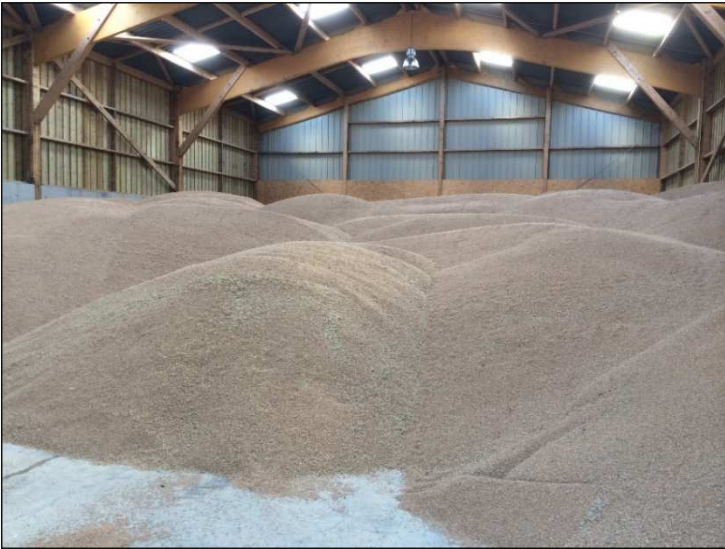
Ventilation céréales avec caniveaux
