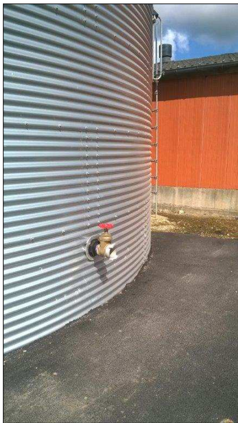
Réserves incendie (sortie directe)
