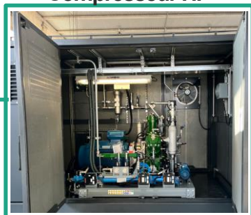
FioKomp HP : Compresseur HP
