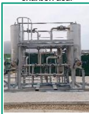
FioCarb : Filtration par charbon actif
