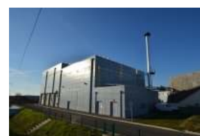
Mars 2025 N°96 : Chaufferies et réseaux de chaleur à biomasse
