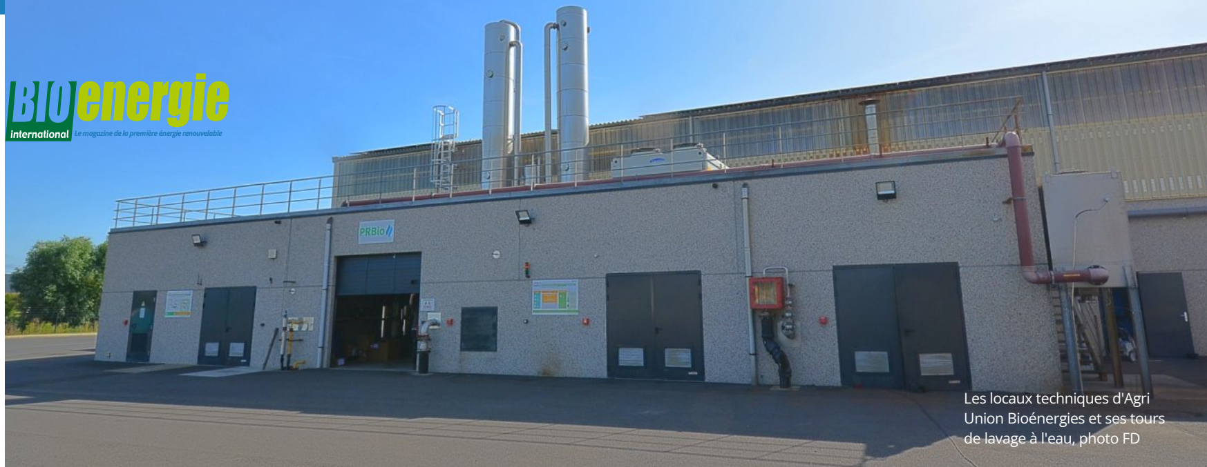
Les colonnes de lavage à l'eau du biogaz, photo FD
