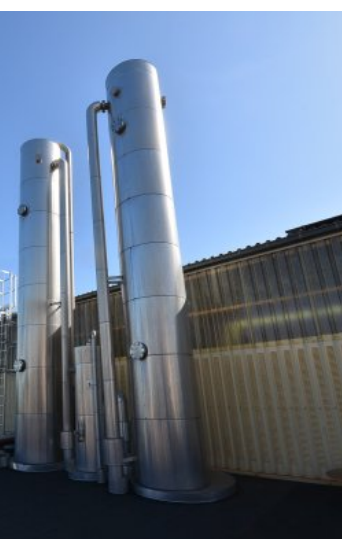
Agri Union Bioénergies purifie son biogaz par lavage à l'eau, photo FD
