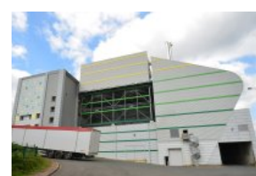
Juin 2025 N°97 : Biocentrales électriques à biocombustibles solides & OM
