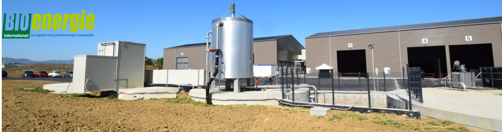
Les cuves d'intrants liquide du processus agricole à Charentay, photo FD
