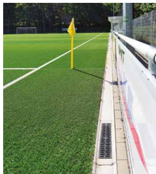
Cunettes en auge sur gazon artificiel.
