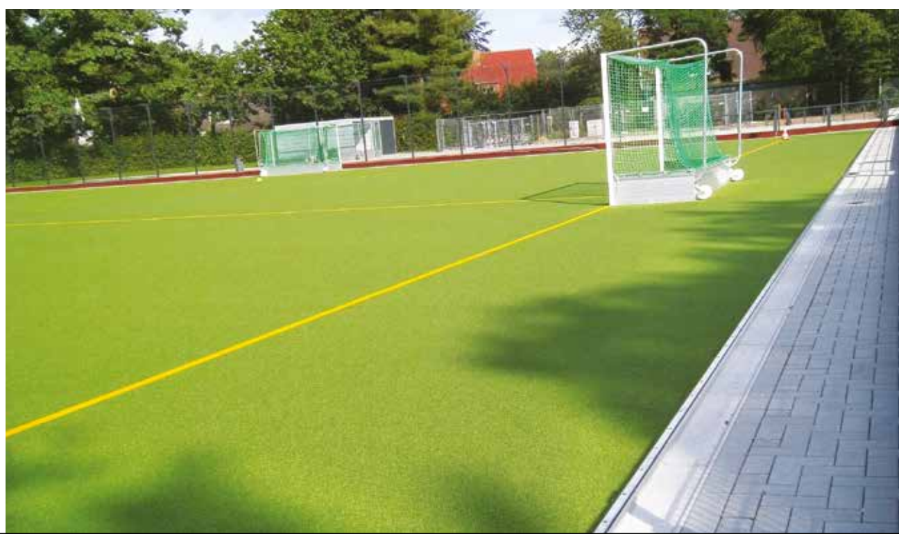
Caniveaux LW100K pour le maintien du gazon synthétique.
